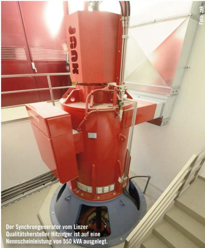
Der Synchrongenerator vom Linzer Qualitätshersteller Hitzinger ist auf eine Nennscheinleistung von 550 kVA ausgelegt.
